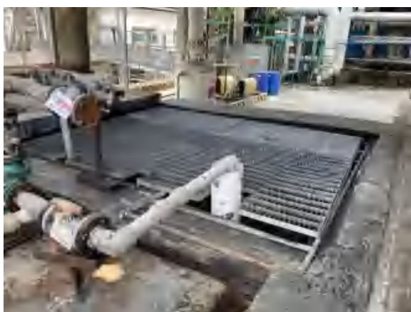
硅树脂生产线有机硅厂环保处理池（碱液池）
