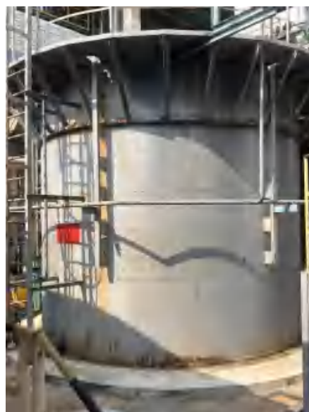
40kt/a F22 装置中和液贮罐及围堰
