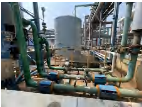
16kt/aF22 装置稀酸槽运输机泵
