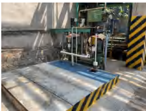
16kt/aF22 装置氯仿计量槽配套的收集池
