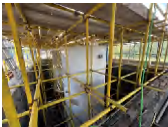
等离子裂解中和池（施工中，由池体改为储罐）
