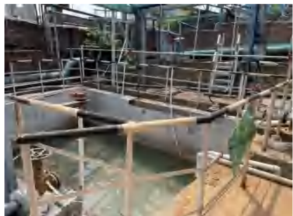
氟化三厂 9000t/a 四氟乙烯单体装置碱液槽及连接的事故池
