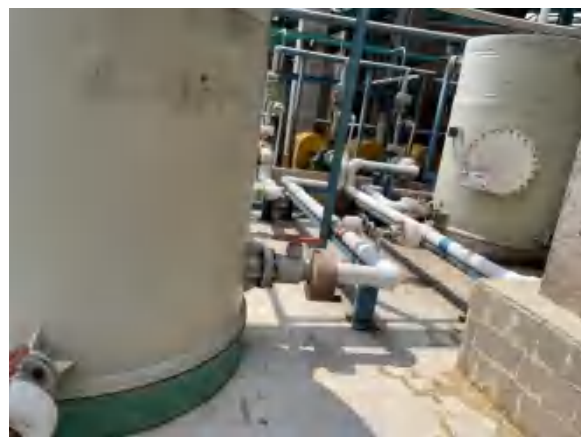
氟化三厂 9000t/a 四氟乙烯单体装置含氟废水收集槽区
