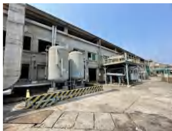
硅树脂生产线二甲苯储罐
