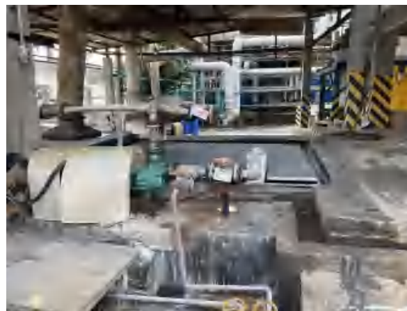
废水收集池运输机泵
