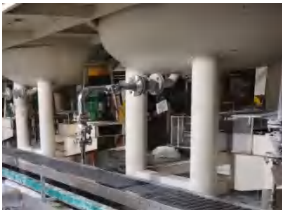
生产区内运输机泵（聚四氟乙烯分散浓缩液装置）
