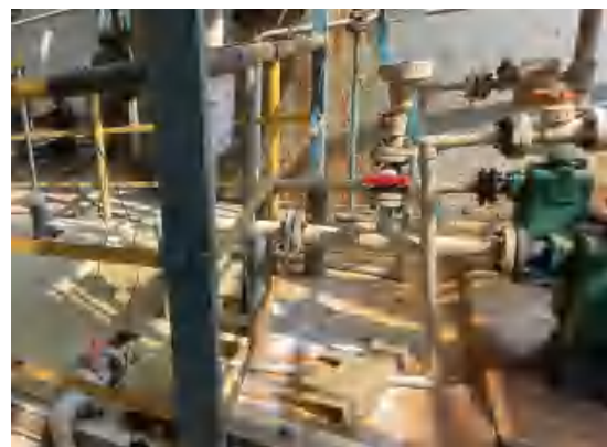
40kt/aF22 装置的废碱收集池（2 处）运输机泵
