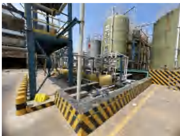
聚合氯化铝生产线液体罐区运输机泵
