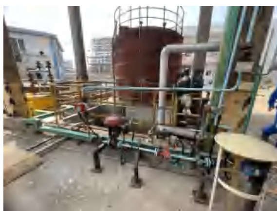
40kt/aF22 装置的废碱收集池（2 处）运输机泵
