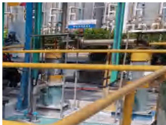
氟化三厂特种分散树脂装置凝聚水收集池运输机泵
