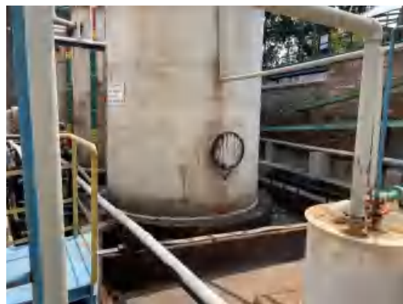
氟化三厂 9000t/a 四氟乙烯单体装置盐酸槽
