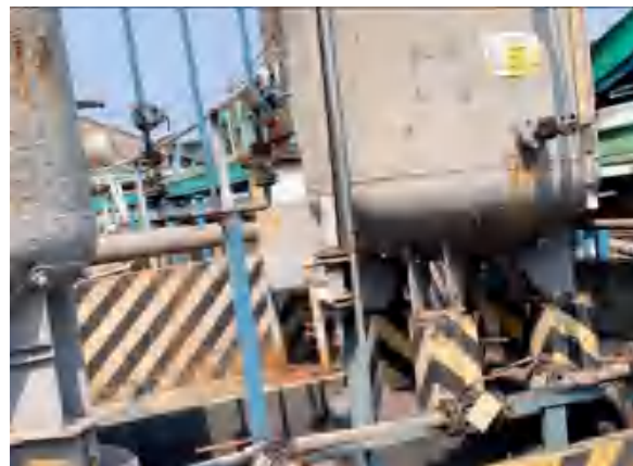
硅树脂生产线甲苯回收罐
