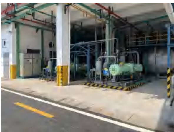
生产区内运输机泵（16kt/aF22 装置）
