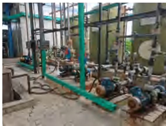
乳液 QQF 酸碱槽区运输机泵
