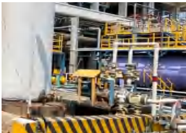
偏氟乙烯生产线碱液槽区运输机泵
