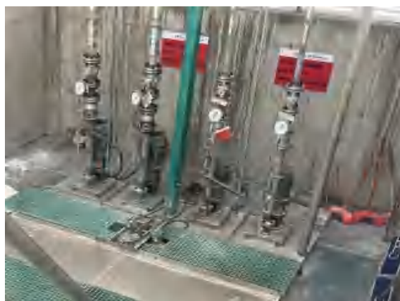
聚偏氟乙烯树脂生产线污水收集池（2处）运输机泵
