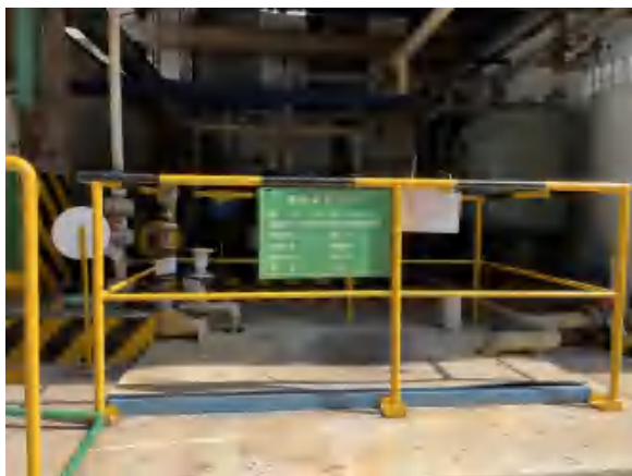
氟橡胶装置废水收集池
