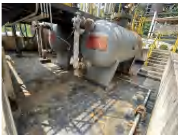
氟化三厂 12000t/a 四氟乙烯单体装置脱水岗位 废硫酸储槽事故应急池
