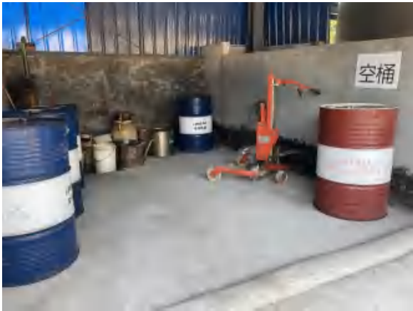
二氟一氯甲烷生产线润滑油间（16kt/aF22 装置）出口缓冲坡及地面情况
