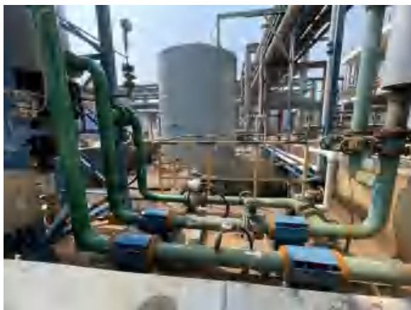
16kt/aF22 装置稀酸槽及配套的收集池
