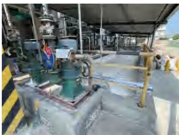
聚偏氟乙烯树脂生产线污水收集池（2处）运输机泵
