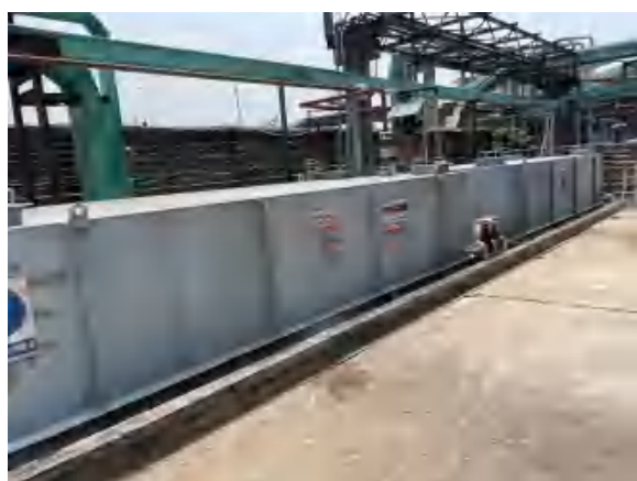
氟化三厂 9000t/a 四氟乙烯单体装置碱液槽及连接的事故池
