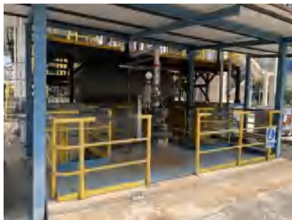
氟化三厂 12000t/a 四氟乙烯单体装置脱水岗位废硫酸储槽机泵
