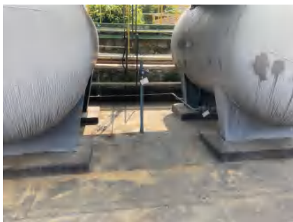
废催化剂收集槽有毒有害气体泄漏检测仪
