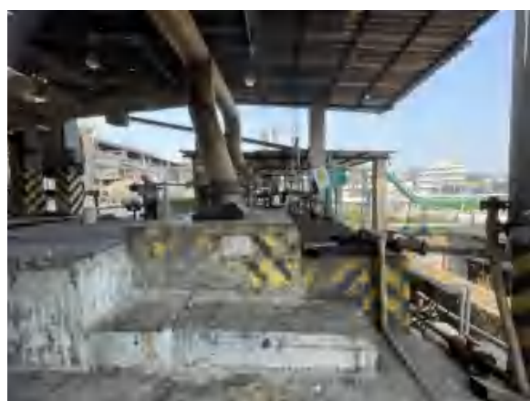
硅树脂生产线有机硅厂环保处理池（中和池）
