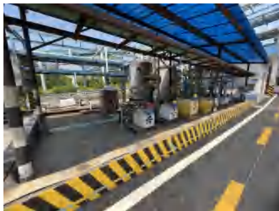
16kt/aF22 装置盐酸循环槽区运输机泵
