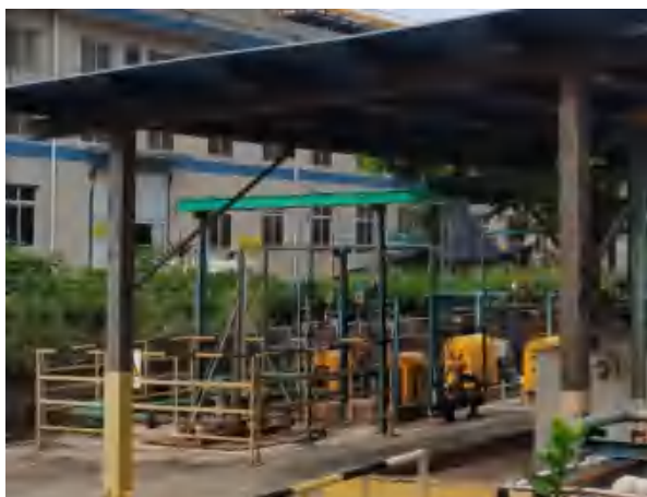
氟化三厂 12000t/a 四氟乙烯单体装置污水收集池、盐酸罐区、碱液槽运输机泵
