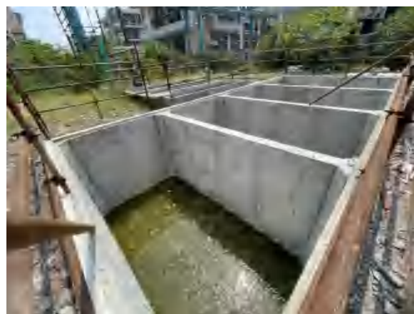
5000 吨悬浮树脂装置冷却水收集池
