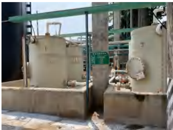
氟化三厂 9000t/a 四氟乙烯单体装置含氟废水收集槽区
