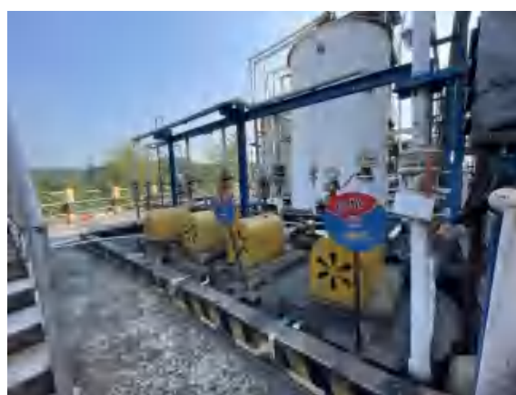
等离子裂解 HF 酸槽运输机泵
